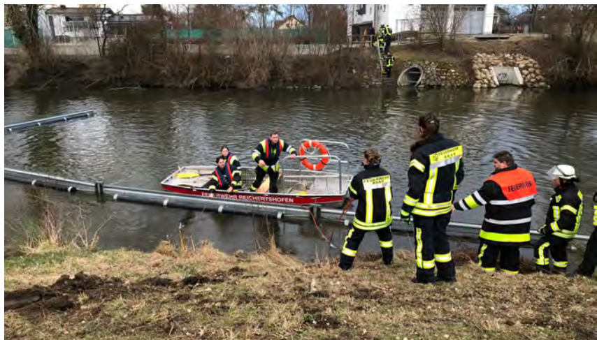
Ölsperre auf Paar eingebracht
