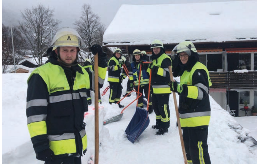
Dach abräumen in Miesbach
