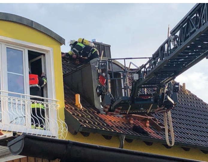
Kontrolle der Dachhaut
