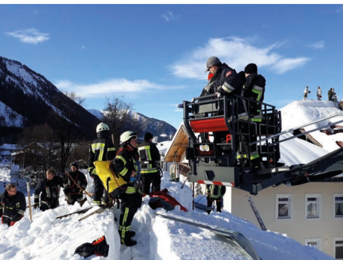
Dach abräumen in Bayrischzell
