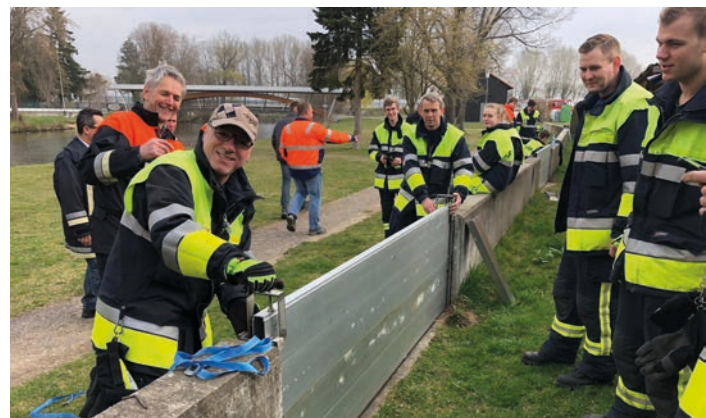
Dammbalken - fertiger Zustand
