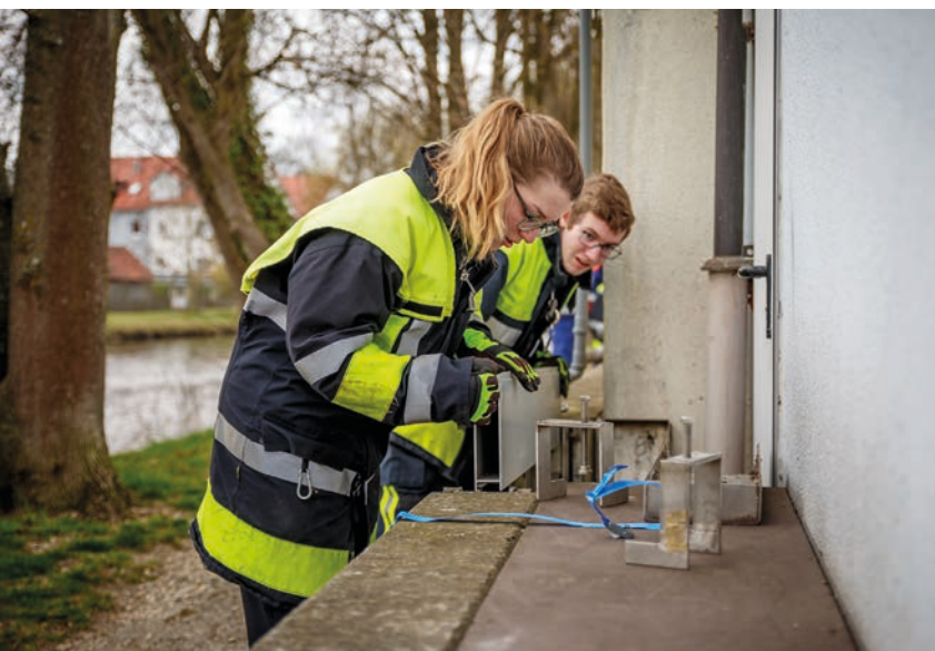
Einbringen der Dammbalken, Quelle: THW Michael Matthes
