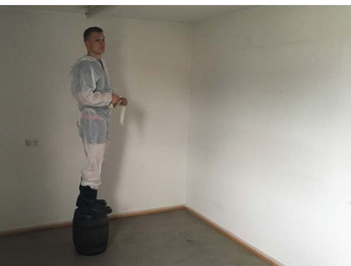
Malerarbeiten im Gerätewartbüro
