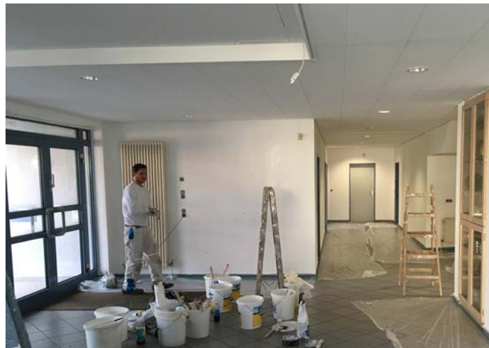
Malerarbeiten der Firma Nastvogel im Foyer
